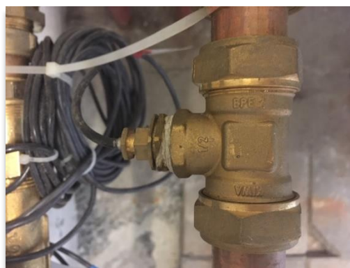
Figuur 6 - Montage in T-Stuk met adapter
