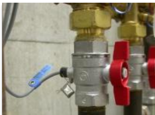
Figuur 5 - Montage in kogelkraan
